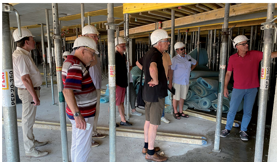
Der Magistrat informiert sich auf der Baustelle über den Baufortschritt
